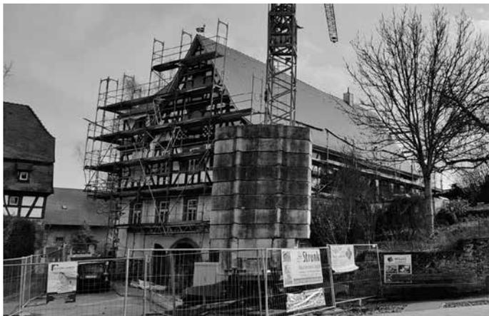
Erst mit Hilfe von Bohrpfehlen ist es gelungen, einen festen Untergrund herzustellen. Neue Streifenfundamente stabilisieren jetzt Kellergewölbe und das massiv gemauerte Erdgeschoss. Das teils kunstvoll verzierte Fachwerk der Etagen darüber und das Dach
