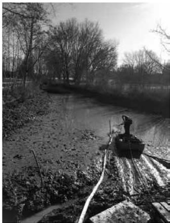
Der Schlamm wurde mit einem Truxor (Amphibienmaschine) an den Rand verfrachtet und von dort aus mit einem Bagger entnommen. Das Material, der entnommene Schlamm wurde im direkt danebenliegenden Freibadgelände aufgesetzt um dort abtrocknen zu können. Durch den Verbleib des Aushubs in der Nähe des Wärmesees hatten die Amphibien und Kleinlebewesen die Möglichkeit, wieder ins Gewässer zurück zu gelangen.
