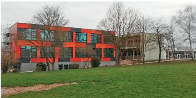
Die anderen beiden Stockwerke und der Verbindungsbau wurden in Modulbauweise durch die Firma ALHO hergestellt, d. h. die Module wurden im Werk komplett mit allen benötigten Installationen vorgefertigt. Der Aufbau der Module erfolgte im November. Anschließend wurden die erforderlichen Anschlussarbeiten im Hauptgebäude durch ortsansässige Handwerker ausgeführt.
