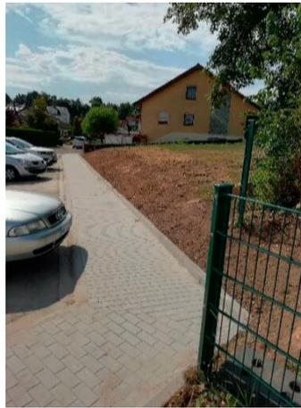
Anschließend wurden 35 m Tiefbordsteine versetzt und 44 m<sup>2</sup> Pflaster verlegt, um den Kindern einen sicheren Weg in den Kindergarten zu ermöglichen.
