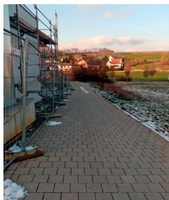
Auf Antrag aus dem Gemeinderat wurde die Instandsetzung des Schotterumfahrtsweges an der Kraichgauhalle mit wasserdurchlässigem Pflaster im Rahmen der Straßenunterhaltungsarbeiten 2020 durch die Firma Klaus Reimold neu hergestellt.
